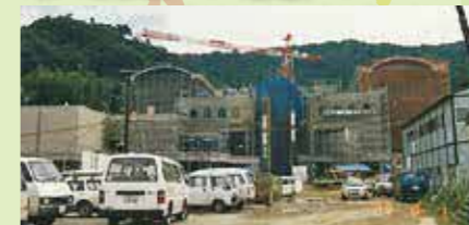
建設途中の四館棟
